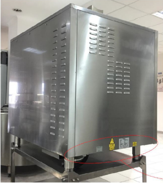
Gazlı Konveksiyonlu Fırının Gaz Bağlantısı
